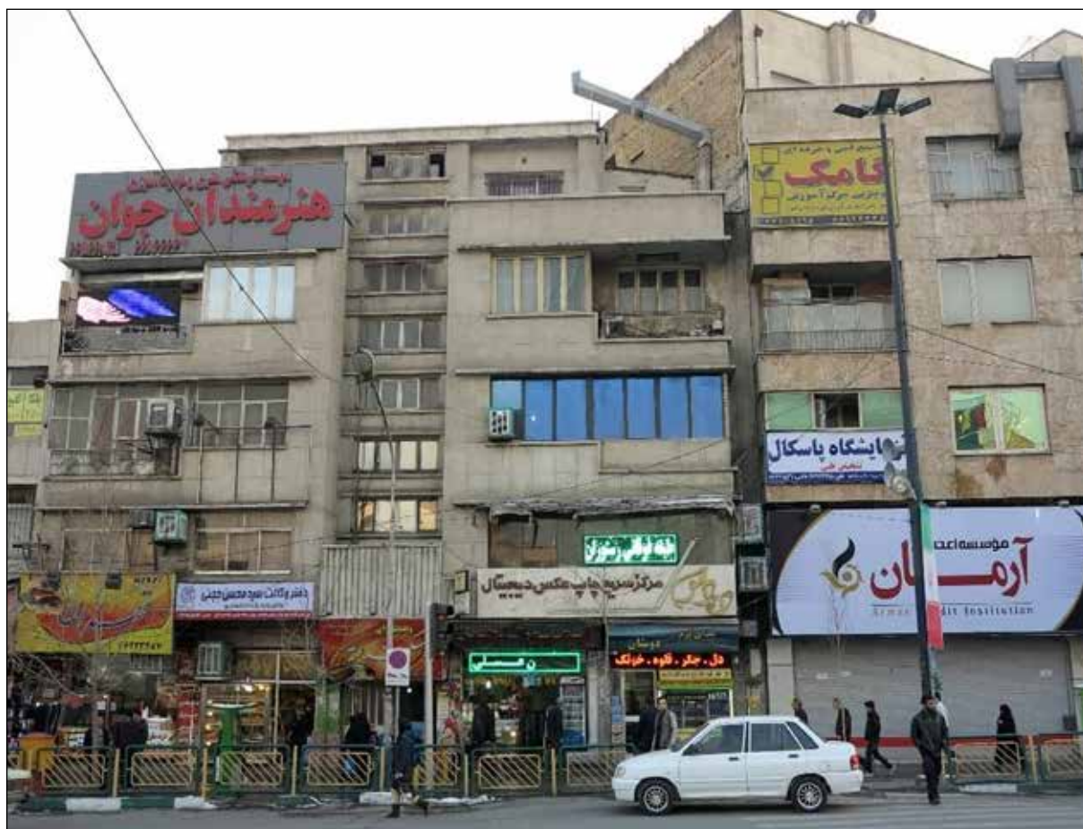
تصویر ۸- ترکیب عناصر ناهمگون ما که از جنبه بصری به منظر شهری آسیب جدی وارد نموده است، تهران: میدان انقلاب، جنبه جنوبی خیابان (نگارنده، ۱۳۹۲).
